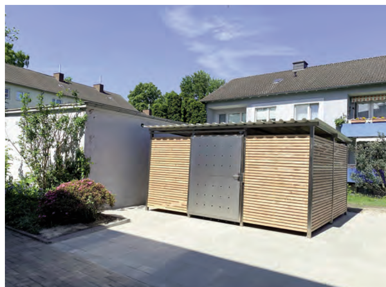
Fahrradgarage Vormholzer Ring 49
